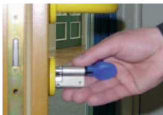
BlueChip cilinder er weer inzetten
