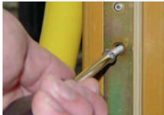
Bevestigingsschroef eruit draaien
